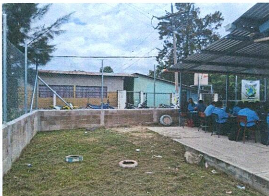
Foto 1: Mejoramiento del levantado de block.
