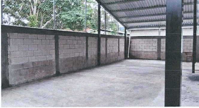
Foto1: Mejoramiento e instalación de puertas plegables de plywood destinada a la división del aula.
