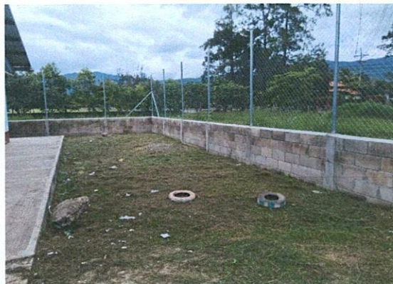
Foto 2: Mejoramiento de la estructura y cubierta de láminas.
