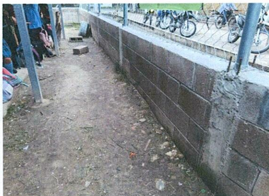
Foto 3: Mejoramiento de la losa del patio.
